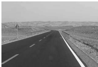
图 1-24 零填零挖路基
