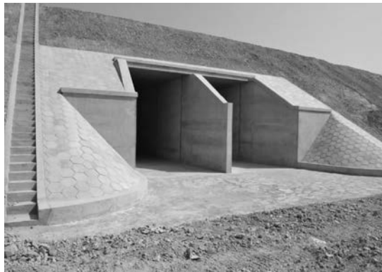
图 1-12 盖板涵洞实景
