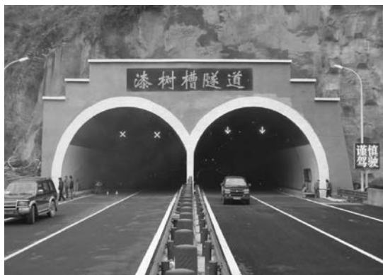
图 1-13 隧道洞门实景
